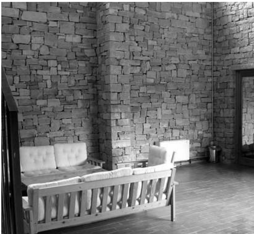
La pedra en sec també s'empra en la construcció d'habitatges.
