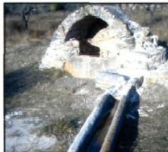
Restauració del povet i recuperació d'una pica i del bassi
