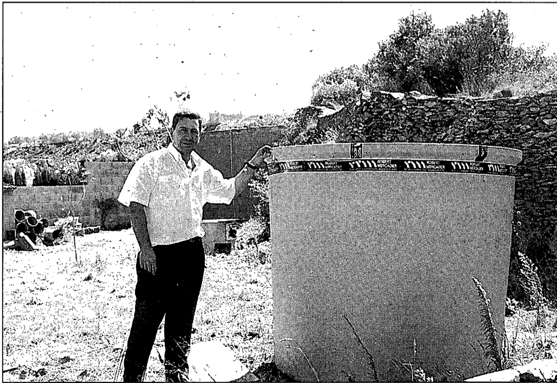
Rafa Martín, al costat del dipòsit d'aigua que estava construint. Foto: ROBERT CARMONA.
